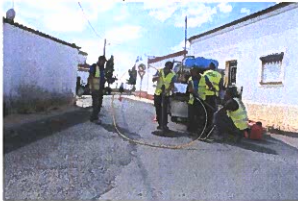
Figura 7. - Inspeção vídeo para deteção de caixas de visita
